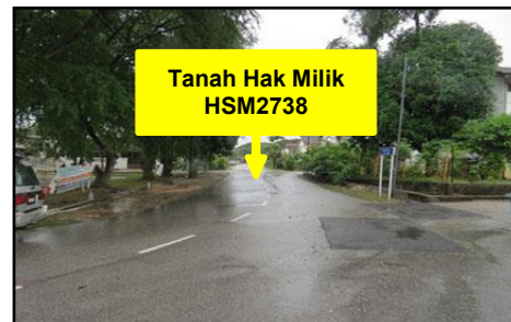
Mukim Kuala Kuantan - Keadaan Tapak Tanah (Jalan) Hak Milik HSM2738 (01.12.2016)
