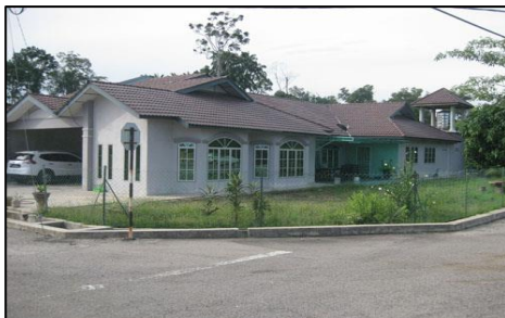
Taman Impiana Rompin, Rompin - Penambahan Ruang Bangunan Tanpa Kelulusan (12.10.2016)
