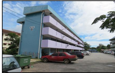
Bandar Kuantan - Blok Perumahan Pangsa Bagi Hak Milik PM53 (21.12.2016)
